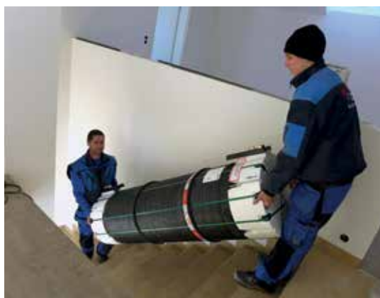
Der Kunststoff-Wärmetank wiegt nur ein Drittel eines herkömmlichen Stahlspeichers und vereinfacht so den Transport über Treppenstufen hinweg.
