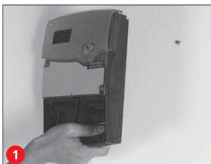
Die Montage darf ausschließlich in trockenen Innenräumen auf ebenem Untergrund erfolgen. Beachten Sie, dass das Gerät für eine einwandfreie Funktion an dem ausgewählten Ort keinen starken elektromagnetischen Feldern ausgesetzt sein darf.
