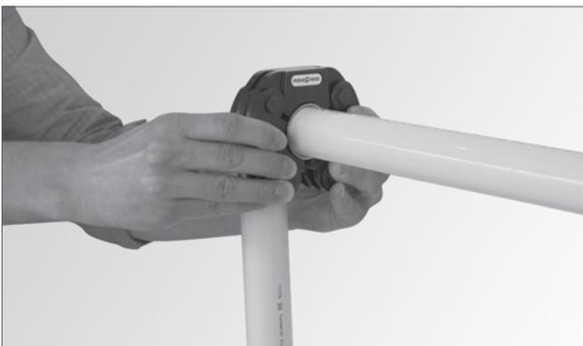
Positionieren der Pressschlinge auf dem Fitting.
