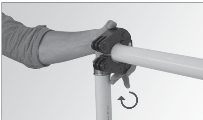
Korrekten Sitz der Pressschlinge auf der Presshülse prüfen und ggf. ausrichten.
