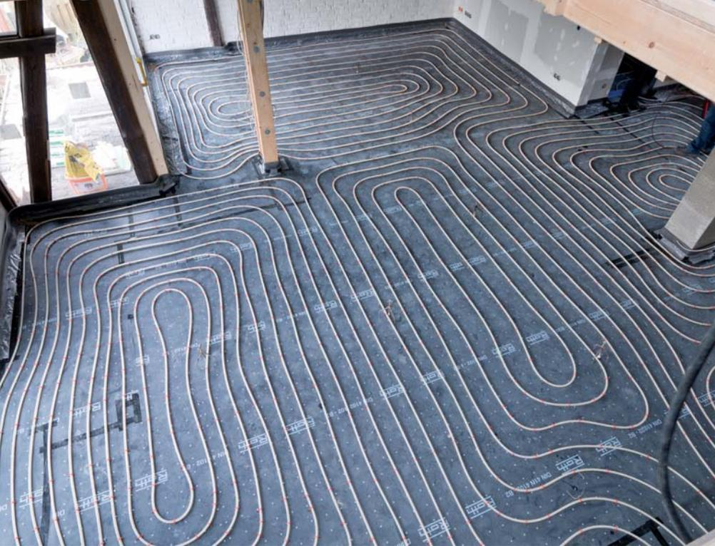
Für das Wohlbefinden wird der maximale Temperaturunterschied zwischen Raumtemperatur und Oberflächentemperatur des Bodens im Aufenthaltsbereich von Räumen sowie Nassräumen auf 9 Kelvin und in Randzonen auf max. 15 Kelvin eingeschränkt. Die berechnete Leistung wird deshalb durch die Grenzkurven für 9 und 15 Kelvin begrenzt.
