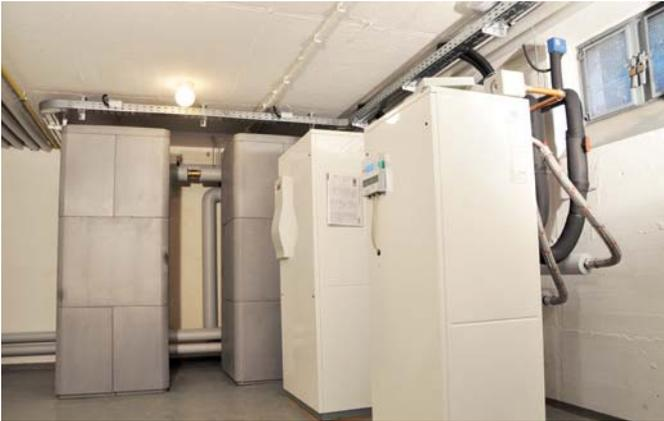
Zwei Roth Thermotanks Quadroline TQ-S 500 Liter und zwei Roth Sole/Wasser-Wärmepumpen TerraCompact sind Teil des innovativen Energiekonzeptes
