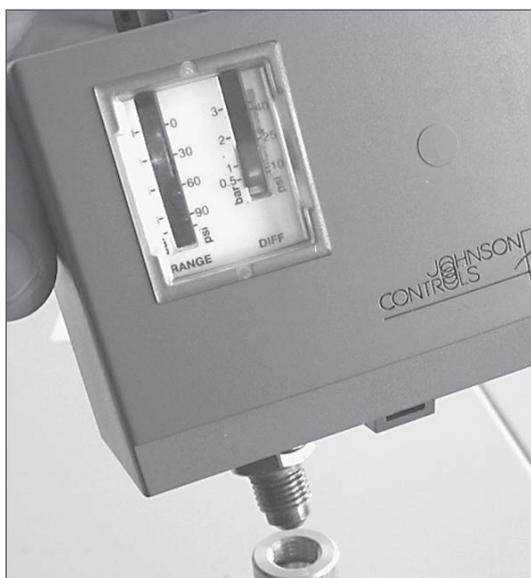
2. Soledruckwächter aufschrauben bis er dicht abschließt. Die Kupferdichtung darf dabei nicht verrutschen.
