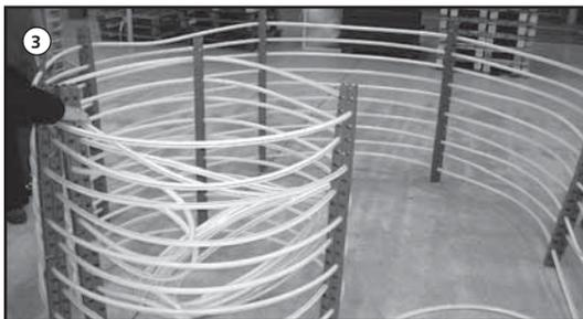
3. Die Registerarme sind vollständig abzurollen und in eine Form von 5 m Länge und 0,8 m Breite zu bringen. Ein einzelner Befestigungsklip dient als Markierung für die Mitte des Registers.
