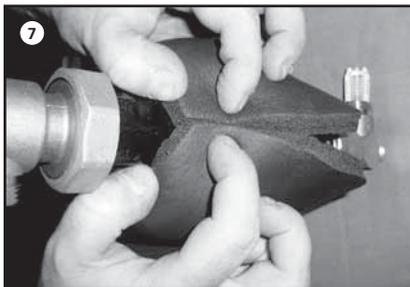
7. Die beiden „Höcker“ müssen am Gussgehäuse der Pumpen zusammengeführt und an den Kanten miteinander verklebt werden. Es darf kein Luftspalt mehr sichtbar sein.
