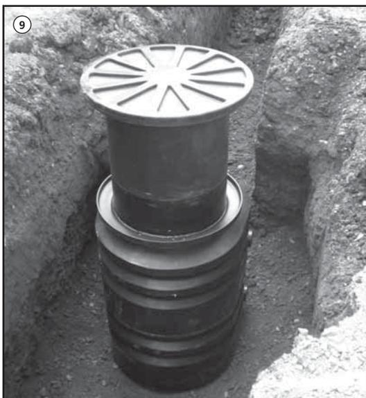
9. Nach Verfüllen der Registergräben ist die Registerstation im Verteilergraben zu setzen. Für einen festen Stand während der Montage empfiehlt es sich den Graben um die Station vorab etwas zu verfüllen. Die Registerstation ist so einzubringen, dass der Deckel mit der Oberkante des fertigen Bodens bündig ist.
