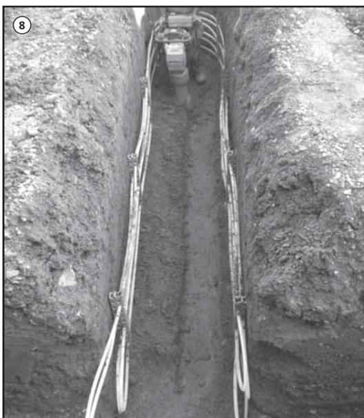
8. Nachdem der Graben zu 1/3 verfüllt ist, ist das Erdreich mittig des Grabens mit Hilfe einer "Rüttelplatte" zu festigen. Diesen Vorgang während der Grabenfüllphase mehrfach wiederholen. Etwa 0,3 m oberhalb jedes Registers sollte ein Markierungsband ins Erdreich gelegt werden, damit bei einer eventuellen späteren Aushebung der Gräben erkannt wird wo die Register beginnen. Dies dient als reine Schutzvorkehrung.
