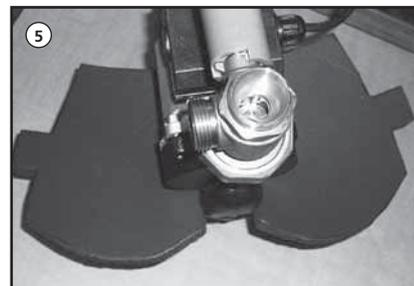
6. Nun muss die Isolierung nach oben geklappt werden und wird mit dem Pumpengehäuse verklebt. Die Kanten der beiden „Zipfel“ werden hinter dem Pumpenmotor zusammengeführt.
