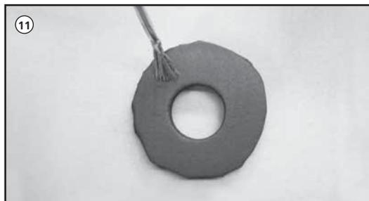
12. Isolierung auf beiden Seiten auf die hydraulische Weiche kleben.
