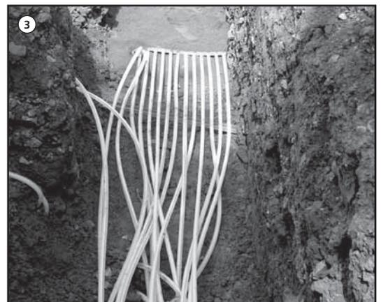
4. Für die Einführung der Anbindeleitung in die Registerstation empfiehlt es sich einzelne Löcher größerer Durchmesser 20 mm zu bohren (siehe auch Bild 2). In der Registerstation die Anbindeleitung an den Verteilerstamm anschließen. Die Sammelleitung von Verteilerstamm zur Wärmepumpe ist bauseits zu erledigen!
