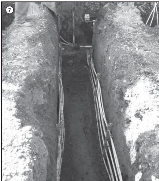
7. Bei den eingebrachten Registern die oberen Befestigungsklips entfernen und die Gräben wieder verfüllen. ACHTUNG! Beim Verfüllen ist darauf zu achten, dass keine großen und scharfkantigen Steine in die Gräben gelangen. Vor dem Verfüllen der Gräben sollten die Anbindeleitungen der Register abgeklebt werden damit kein Schmutz in die Rohre gelangt. Außerdem sollten Vor- und Rücklauf eindeutig gekennzeichnet werden um Fehler später beim Anschließen am Verteiler zu vermeiden.
