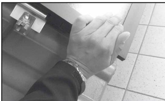
Um einer Fehlstellung der Steckanschlüsse vorzubeugen, müssen die Kollektoren auf Höhe der Anschlüsse unten und oben geschoben werden. Durch Schieben in der Mitte des Kollektors kann eine Fehlstellung auftreten.
