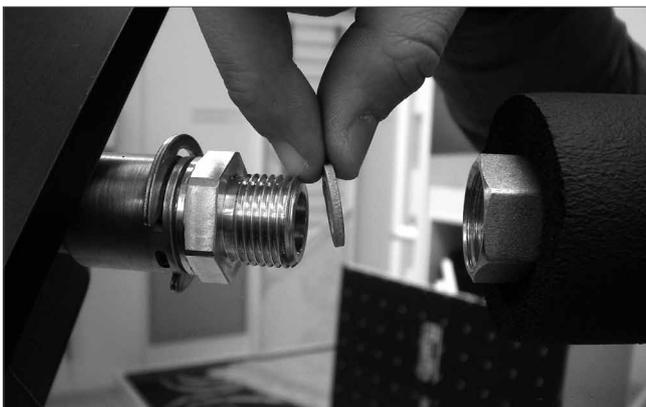
Bei der Montage der Wellschlauch-Überwürfe auf korrekten Sitz der Flachdichtungen achten. Beim Festziehen der Gewindeverbindungen am Kollektor unbedingt dagegenhalten. Anderenfalls kann der Kollektor zerstört werden.
