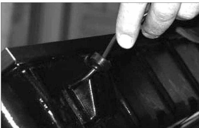
Zur Fühlermontage Gummimuffe entnehmen, Fühler durchfädeln, Wärmeleitpaste auftragen und bis zum Anschlag in Tauchhülse einführen. Anschließend Gummimuffe bis hinter Konterlippe eindrücken.
