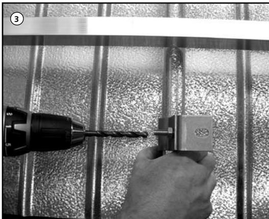
3. Mit Metallbohrer  $\varnothing$  8 untere Halterbohrung durchbohren und mit weiterer Schraube befestigen.
