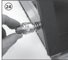
**21. - 24.** Bei der Betriebsweise eines einzelnen und jedes weiteren Kollektors ist auf eine diagonale Durchströmung zu achten. Hierzu sollten die End- und Anschlussstopfen wie beispielhaft dargestellt vorgesehen und mit einem dazugehörigen Sicherungsring befestigt werden.
