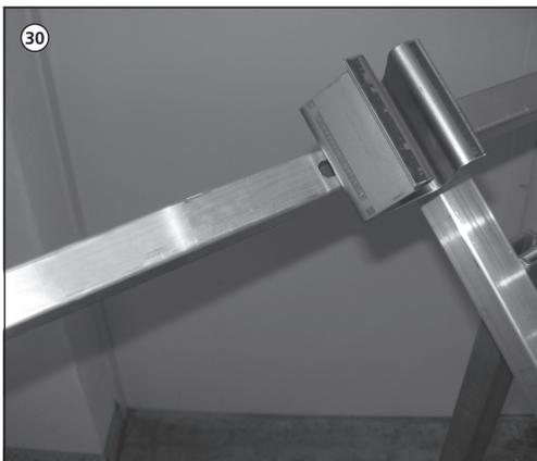
**30.** Die obere und untere waagerechte Montageschiene ist aufzustecken und zu fixieren.
