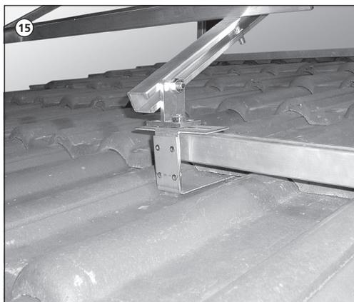
**15./16.** Profilschiene unterhalb des Universalbefestigungsankers auf das U-Profil 25 x 10 x 25 schieben und mit Sechskantmutter M10 anziehen.
