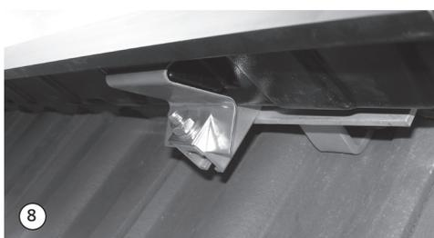
**3./4.** Profilschienen mit Sechskantschrauben M 10 x 30 und U-Profilescheiben durch die Langlöcher der Dachhaken anschrauben. Darauf achten, dass das geschlossene Langloch unten sitzt (siehe Detail B, Seite 3).
