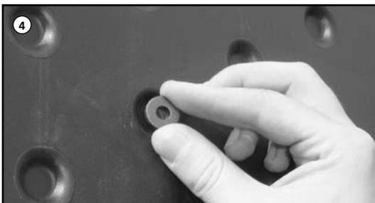
**4.** Bohren Sie mithilfe der mitgelieferten Führungsscheibe eine Bohrung in die Noppen, die später zur Befestigung des Kollektors dienen soll.
