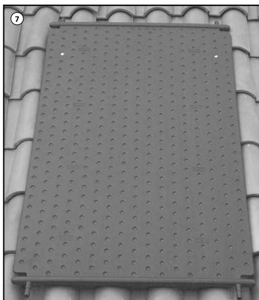
8. Montieren Sie die übrigen Kollektoren, indem Sie die oben genannten Schritte wiederholen.
