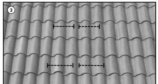
4. Bringen Sie zunächst den ersten Sparrenanker auf dem Dach an und legen Sie ausgehend von diesem Sparrenanker die Position des nächsten fest. Hinweis: Die einzelnen Kollektoren werden nur von den beiden Sparrenankern im oberen Bereich gehalten. Im unteren Bereich der Kollektoren ist eine Befestigung nicht erforderlich, ausgenommen ist die unterste Kollektorreihe.
