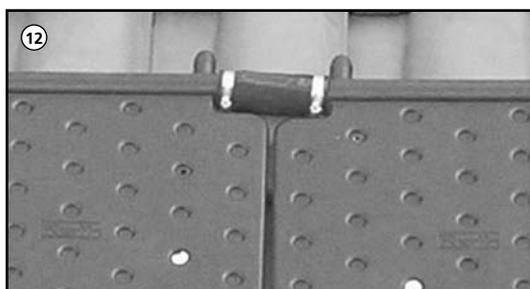
**12.** Zur hydraulischen Verbindung der Kollektoren untereinander sind je nach benötigtem Durchmesser (25 oder 40) die im Lieferzustand geschlossenen Abgänge mittels Messer aufzuschneiden. Die offenen Enden werden mit den Gewebeschläuchen verbunden und mittels Schlauchschelle fixiert.
