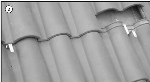
**2.** Montieren Sie die Sparrenanker auf der Dachhaut. Messen Sie die Position exakt aus, damit die Klammern später genau auf die Noppen des Kollektors ausgerichtet sind.
