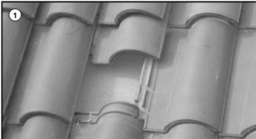
**1.** Entfernen Sie den entsprechenden Dachziegel, nachdem Sie festgelegt haben, wo die Sparrenanker angebracht werden sollen. Wählen Sie unbedingt das für Ihren Dachziegel geeignete Befestigungsset.
