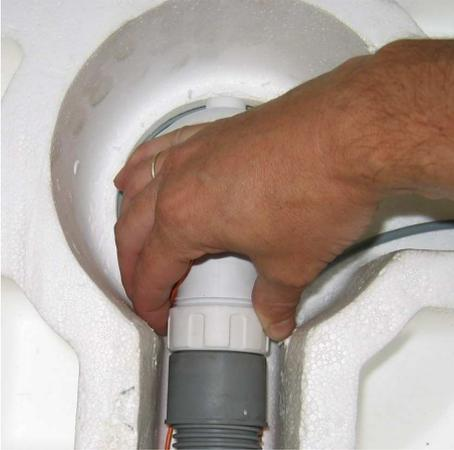
Anschluss des flexiblen Abwasserschlauches am Siphon lösen und Abwasserschlauch komplett entnehmen.
