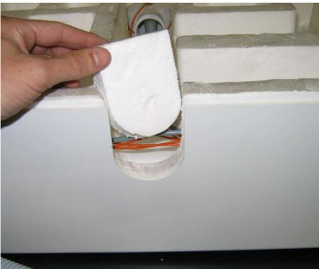
Wannenträger an der dafür vorgesehenen Stelle ausschneiden. Bei Bedarf einen eigenen Durchbruch für das Abwasserrohr herstellen. Siehe hierzu alternative Anschlussmöglichkeiten auf Seite 4 dieser Montageanleitung.
