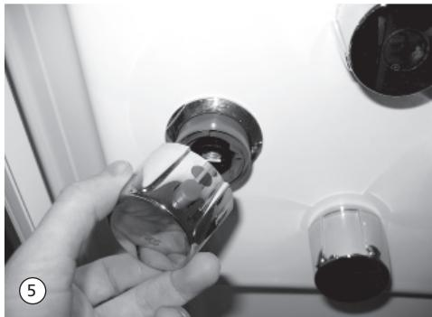
5./6. Wasserzufuhr zur Armatur absperren.
