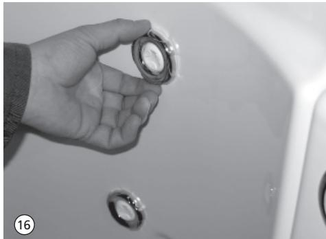
16./17. Die Massagedüsen sollten von Zeit zu Zeit bewegt werden und mit Armaturenfett leicht eingefettet werden, um die Leichtgängigkeit aufrecht zu erhalten. Die Massagedüsen können zur Reinigung demontiert werden. Hierfür ist der äußere, verchromte Ring der Düse abzudrehen. Danach können die Bestandteile der Düse komplett entnommen und gereinigt werden. Wir empfehlen die Reinigung mit einer Bürste unter fliesendem Wasser.
