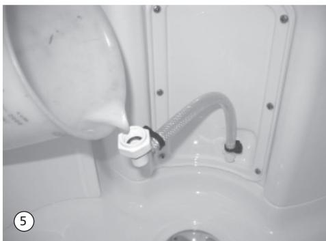
5. Füllen Sie ca. 0,5 Liter Entkalkerflüssigkeit über den Einfüllschlauch in den Dampfgenerator ein.
