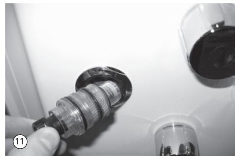
12. Überwurfverschraubung wieder montieren.
