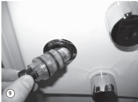
10. Filter des Thermoelements mit einer weichen Bürste reinigen oder, falls beschädigt Thermoelement austauschen.
