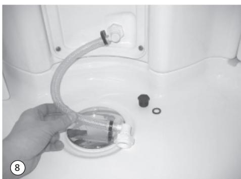
8. Entfernen Sie den Verschlussstopfen des Einfüllschlauches erneut und entleeren Sie den Dampfgenerator direkt in den Siphon der Duschkabine.
