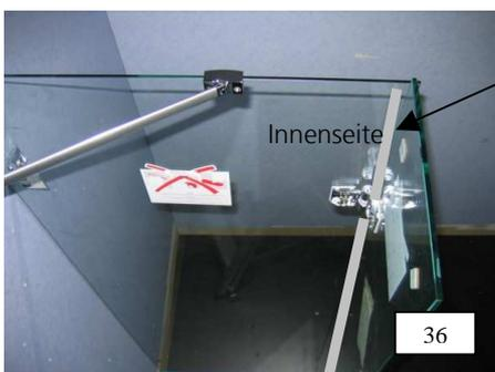
36. Innen muss zusätzlich am Stoß von Seitenwand zum Seitenteil auf der ganzen Länge lotrecht versiegelt werden.
