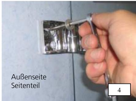
4. Anschließend beide Scheiben erneut ausrichten und jeweils beide Beschläge mit je 2x Schrauben 6 x 80 mm und 2x U- Scheibe 6,4 mm befestigen.
