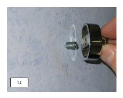
15. Alternativ Stockschraube M6 x 60 zunächst in die Gelenkplatte eindrehen. Danach vormontierte Gelenkplatte mit Maulschlüssel SW 8 in Dübel eindrehen.
