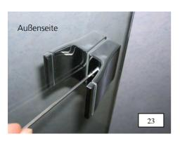
23. Zweite Griffhälfte zusammen mit der Griffunterlage von außen über die Befestigungshülse schieben und durch Eindrehen des Gewindestiftes M5 auf der Befestigungshülse fixieren. Gewindestift hierbei fest anziehen.
