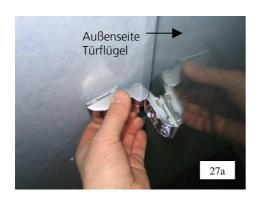
26. Beschlagabdeckungen am Türflügel und am Seitenteil montieren. Dabei Zuordnung Links "L" und Rechts "R" beachten. Vor Montage der türseitigen Beschlagabdeckungen nochmals alle Befestigungsmuttern M8 mit einem Drehmoment von 15 Nm anziehen.
