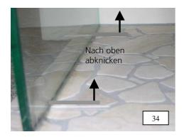
34. Die Verglasungsklötze unter der Seitenwand und dem Seitenteil müssen so abgeknickt werden, dass jeweils noch ein Stück davon unter den Scheiben verbleibt. Nun kann mit der Vorbereitung zur Versiegelung begonnen werden Montageschritte
