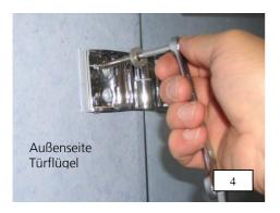
4. Anschließend beide Scheiben erneut ausrichten und jeweils beide Beschläge mit je 2x Schrauben 6 x 80 mm und 2x U- Scheibe 6,4 mm befestigen. Unterer Kantenschutz an der Tür kann nun entfernt werden.
