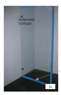
2. Je nach Bedarf 2x Verglasungsklotz in 2 oder 3 mm Stärke an die Position der Seitenwand auf den Wannenrand oder Fliesenboden legen.
