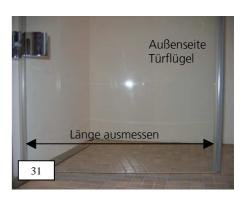
32. Von der Vorderkante der Ausklinkung muss die ermittelte Länge dann nach hinten zum Ende der Dichtung hin übertragen werden.
