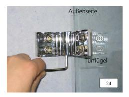
24. Achtung! Die Einstellung am Türflügel wie in diesem Montageschritt beschrieben, muss zwingend durchgeführt werden, da sonst der Hubmechanismus nicht arbeitet.
