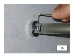
Das Halterohr wieder positionieren und Verbindung zur Gelenkplatte durch Eindrehen des Gewindestiftes M4 herstellen. Montageschritte
