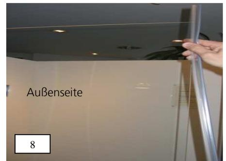
9. Falls erforderlich lässt sich der Türflügel zusätzlich noch über den Beschlag ausrichten. Hierzu mit geeignetem Montagewerkzeug SW 13 die Befestigungsmuttern M8 lösen und Einstellung vornehmen. Achtung vor dem Lösen der Befestigungsmuttern untere Scheibenkanten mit beiliegendem Kantenschutzprofil sichern. Die Befestigungsmuttern M8 sind anschließend mit einem Drehmoment von 15 Nm anzuziehen.
