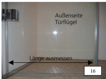
16. Die Länge der Wannendichtung wird zwischen Türmagnetdichtung und Balgdichtung gemessen.
