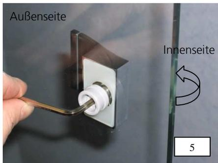
5. Erste Griffhälfte gemeinsam mit der Griffunterlage auf der Innenseite der Scheibe anlegen und mittels Senkschraube M6 x 20 und der Befestigungshülse aus Kunststoff von der Außenseite her durch die Bohrung hindurch befestigen.
