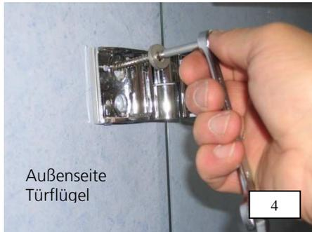
4. Anschließend beide Scheiben erneut ausrichten und jeweils beide Beschläge mit je 2x Schrauben 6 x 80 mm und 2x U- Scheibe 6,4 mm befestigen. Unterer Kantenschutz an der Tür kann nun entfernt werden.
