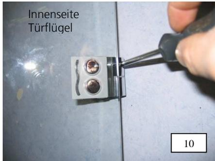
10. Nach korrekter Einstellung des Türflügels und des Seitenteiles zueinander, muss die Sicherungsschraube M3 fest angezogen werden. Sie verhindert das ungewollte Aushängen des Türflügels. Sofern die Notwendigkeit besteht den Türflügel nochmals auszuhängen, ist diese Schraube vorher zu lösen.
