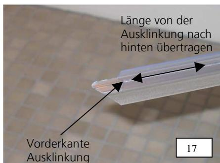
17. Von der Vorderkante der Ausklinkung muss die ermittelte Länge dann nach hinten zum Ende der Dichtung hin übertragen werden.
