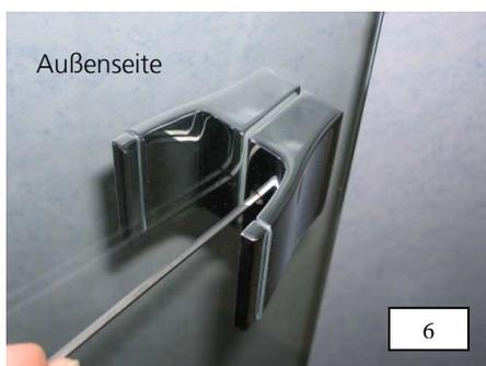
6. Zweite Griffhälfte zusammen mit der Griffunterlage von außen über die Befestigungshülse schieben und durch Eindrehen des Gewindestiftes M5 auf der Befestigungshülse fixieren. Gewindestift hierbei fest anziehen.
