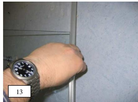
14. Balgdichtung unten zur Duschfläche mit ca. 1 mm Spalt montieren. Die Balgdichtung darf nicht auf der Duschfläche aufsitzen. Die Länge wird mit der Türscheibenoberkante bündig zugeschnitten.
