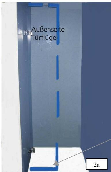
2. Je nach Bedarf 2x Verglasungsklotz in 2 oder 3 mm Stärke an die Position des Seitenteiles auf den Wannrand oder Fliesenboden legen. Entsprechendes Seitenteil aufnehmen (Bezeichnung oben außen links und rechts beachten) Kantenschutz unten und wandseitig vom Seitenteil entfernen und vorsichtig auf den Verglasungsklotzen absetzen.
