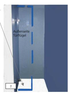
3. Tür an die Markierung setzen, lotrecht ausrichten und Beschläge an die Wand schwenken.
