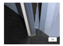
10. Das 6 mm U- Profil wird nun in das 8 mm U- Profil eingeschoben.
