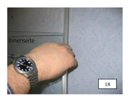
Balgdichtung ebenfalls oben einige Zentimeter auf die hintere Scheibenkante des Türflügels aufstecken.
