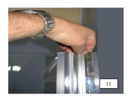
11. Die Türmagnetdichtungen am Türflügel oben ebenfalls einige Zentimeter aufstecken. Bündig mit Türscheibenunterkante montieren und an ihrer Oberkante abschneiden. Bitte beachten, die Dichtungen müssen sich gegenseitig anziehen (Polarität). Tür und schließseitige Profileinheit miteinander ausrichten. Hierzu muss das 6 mm U- Profil entsprechend zum Türflügel eingestellt werden.
