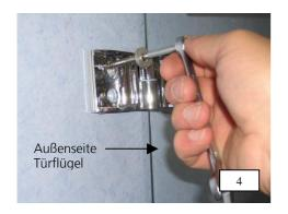
Anschließend Türflügel erneut ausrichten und jeweils beide Beschläge mit je 2x Schrauben 6 x 80 mm und 2x U- Scheibe 6,4 mm befestigen. Unterer Kantenschutz an der Tür kann nun entfernt werden. Montageschritte
