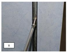
Türmagnetdichtung oben auf das 6 mm U- Profil einige Zentimeter aufstecken, somit wird ein abknicken verhindert.
