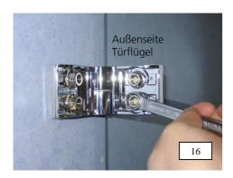
16. Falls erforderlich lässt sich der Türflügel zusätzlich noch über den Beschlag ausrichten. Hierzu mit geeignetem Montagewerkzeug SW 13 die Befestigungsmuttern M8 lösen und Einstellung vornehmen. Achtung vor dem Lösen der Befestigungsmuttern untere Scheibenkanten mit beiliegendem Kantenschutzprofil sichern. Die Befestigungsmuttern M8 sind anschließend mit einem Drehmoment von 15 Nm anzuziehen. Montageschritte
