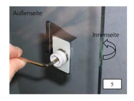
Erste Griffhälfte gemeinsam mit der Griffunterlage auf der Innenseite der Scheibe anlegen und mittels Senkschraube M6 x 20 und der Befestigungshülse aus Kunststoff von der Außenseite her durch die Bohrung hindurch befestigen.
