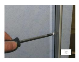
12. Schließt die Tür optimal, dann können die U- Profile (Schließseitige Profileinheit) miteinander verbohrt ) verschraubt werden. Hierzu werden 3 Bohrungen Durchm. 2,3 mm gebohrt und 3x Linsenkopfschrauben 2,9 x 9,5 mm verwendet. Vor dem Verschrauben muss je eine Rosette auf jede Schraube aufgeschoben werden.
