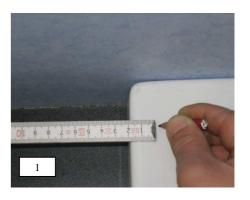
2. Die Tür auf dem unteren Kantenschutz absetzen, so wird der Ausgleich zur Abtrennungshöhe hergestellt. Kantenschutz an der Tür vorerst nur wandseitig entfernen. Die lotrechte Abweichung der Wandschräge darf max. + / - 2 mm betragen.
