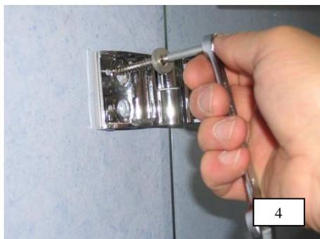
4. Seitenteil erneut ausrichten und beide Beschläge mit je 2x Schrauben 6 x 80 mm und 2x U- Scheibe 6,4 mm befestigen.
