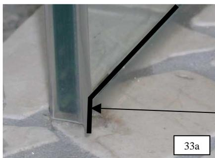
33. Zusätzlich wird die Spaltdichtung am anschlagseitigen Seitenteil im Bodenbereich nur auf der Innenseite mit Silikon versiegelt.
