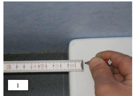
2. Je nach Bedarf Verglasungsklötze in 2 oder 3 mm Stärke an die Position der Scheibe auf den Wannенrand oder Fliesenboden legen (siehe Pfeil). Entsprechendes Seitenteil aufnehmen (Bezeichnung oben außen links und rechts beachten) Kantenschutz unten und wandseitig vom Seitenteil entfernen und vorsichtig auf den Verglasungsklötzen absetzen.
