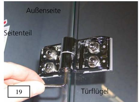
20. Falls erforderlich lässt sich der Türflügel zusätzlich noch über den Beschlag ausrichten. Hierzu mit geeignetem Montagewerkzeug SW 13 die Befestigungsmuttern M8 lösen und Einstellung vornehmen. Achtung vor dem Lösen der Befestigungsmuttern untere Scheibenkanten mit beiliegendem Kantenschutzprofil sichern. Die Befestigungsmuttern M8 sind anschließend mit einem Drehmoment von 15 Nm anzuziehen.
