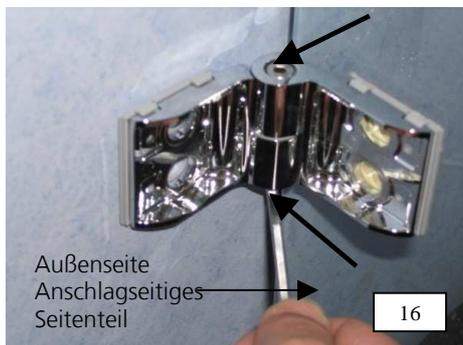
16. Schließseitiges Seitenteil ebenfalls parallel zur Duschfläche ausrichten. Die beiden Schrauben an den jeweiligen Wandwinkeln können nun befestigt werden (siehe Pfeile).
