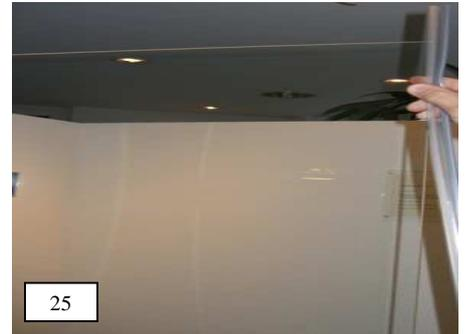
26. Spaltdichtung ebenfalls oben einige Zentimeter auf das Seitenteil aufstecken. Darauf achten, dass sich die Dichtlippe auf der Innenseite befindet. Unten wird sie auf die Duschfläche aufgesetzt und anschließend mit der Scheibenoberkante bündig zugeschnitten.
