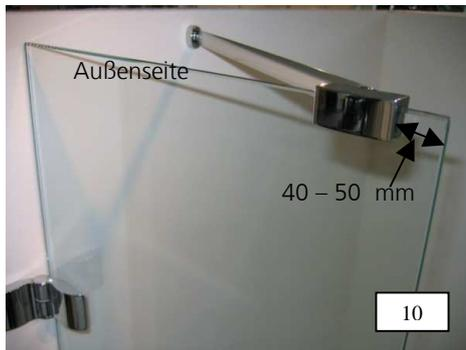
10. Unifix mit Scheibenhalter auf das Seitenteil aufstecken. Den Scheibenhalter des vormontierten Halterohres im Abstand von ca. 40-50 mm zur vorderen Scheibenkante auf das Seitenteil aufstecken und mit dem vorderen Gewindestift M10 auf der Scheibe festklemmen.
