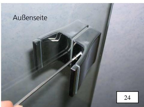
24. Zweite Griffhälfte zusammen mit der Griffunterlage von außen über die Befestigungshülse schieben und durch Eindrehen des Gewindestiftes M5 auf der Befestigungshülse fixieren. Gewindestift hierbei fest anziehen.
