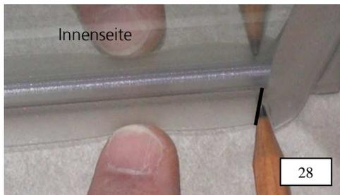
28. Damit die Dichtlippe durchgehend am Türflügel anliegt, muss wie dargestellt die Wannendichtung an der Vorderkante der Spaltdichtung angezeichnet werden.
