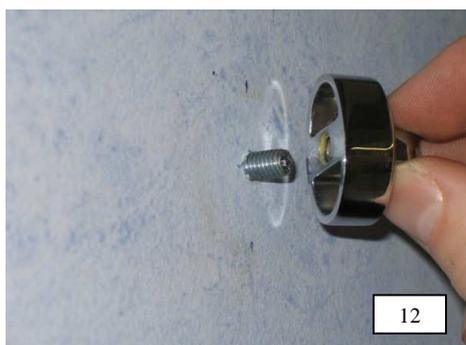
12. Gelenkkopf wieder von der Gelenkplatte lösen. Lochdurchmesser 8 mm an markierter Position bohren. Dübel setzen und Stockschraube M6 x 60 bis auf eine Restlänge von 6 – 8 mm eindrehen. Anschließend die Gelenkplatte aufschrauben und senkrecht ausrichten.
