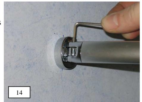
15. Parallele und lotrechte Ausrichtung des Seitenteiles zur Duschfläche prüfen und eventuell korrigieren, danach Scheibhalter mit dem vorderen Gewindestift M10 am Seitenteil fixieren. Bei korrekter Position das Halterohr vom Scheibhalter mit Gewindestift M4 lösen (siehe Pfeil), und mit hinterem Gewindestift M10 ebenfalls fixieren. Anschließend das Halterohr wieder mit Scheibhalter verbinden.
