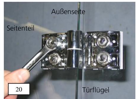
21. Nach korrekter Einstellung des Türflügels die beiden Sicherungsschrauben M3 fest anziehen. Die obere Schraube verhindert das ungewollte Aushängen des Türflügels. Sofern die Notwendigkeit besteht den Türflügel nochmals auszuhängen, ist diese Schraube vorher zu lösen. Die untere Schraube sichert zusätzlich die Fixierschraube des Hubrings gegen Lösen. Falls der Hubring neu justiert werden muss, ist diese Schraube vorher zu lösen.
