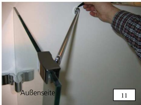
11. Das Halterohr an die Wand schwenken und die Position der Befestigungsbohrung anzeichnen. Dabei waagerechte Ausrichtung des Halterohres beachten.
