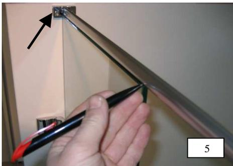
5. Montage Unifix Halterrohr. Das Unifix Halterrohr wird nur auf das anschlagseitige Seitenteil montiert. Seitenteil parallel zur Duschfläche ausrichten. Vormontiertes Halterrohr auf das Seitenteil ablegen. Scheibenhalter dazu an der Wand positionieren (siehe Pfeil). Länge bis zur Scheibenvorderkante anzeichnen.
