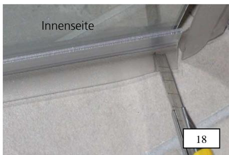
18. Anschließend wird nur der flexible Abweiser ausgeklinkt.
