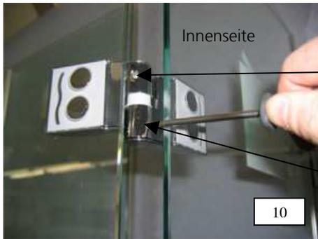
10. Nach korrekter Einstellung des Türflügels die beiden Sicherungsschrauben M3 fest anziehen. Die obere Schraube verhindert das ungewollte Aushängen des Türflügels. Sofern die Notwendigkeit besteht den Türflügel nochmals auszuhängen, ist diese Schraube vorher zu lösen. Die untere Schraube sichert zusätzlich die Fixierschraube des Hubrings gegen Lösen. Falls der Hubring neu justiert werden muss, ist diese Schraube vorher zu lösen.
