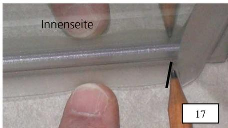
17. Damit die Dichtlippe durchgehend am Türflügel anliegt, muss wie dargestellt die Wannendichtung an der Vorderkante der Spaltdichtung angezeichnet werden.
