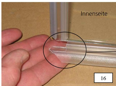
16. Wannendichtung ausklinken, und am Türflügel montieren. Die Länge wird bündig mit der Scheibenhinterkante zugeschnitten.
