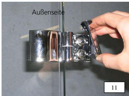
11. Beschlagabdeckungen montieren. Dabei Zuordnung Links „L“ und Rechts „R“ beachten. Vor Montage der Beschlagabdeckungen nochmals alle Befestigungsmuttern M8 mit einem Drehmoment von 15 Nm anziehen.
