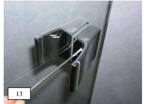
14. Türmagnetdichtungen auf die Türflügel oben einige Zentimeter aufstecken, somit wird ein abknicken verhindert. Mit der Unterkante der Türflügel bündig montieren und an der Oberkante abschneiden. Bitte darauf achten, dass sich die Dichtungen der beiden Türflügel gegenseitig anziehen (Polarität). Türflügel zueinander ausrichten, wenn notwendig wie in den Montageschritten 9 – 11 beschriebene Einstellung vornehmen.
