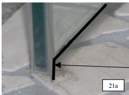
21. Spaltdichtung im Bodenbereich nur auf der Innenseite mit Silikon versiegeln.
