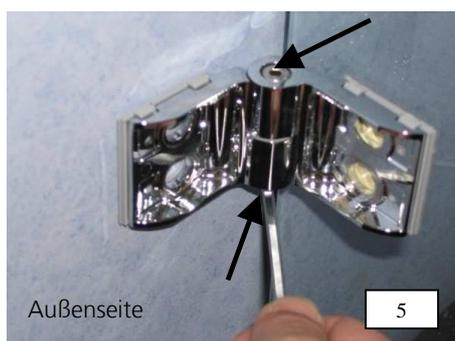
5. Seitenteil parallel zur Duschfläche ausrichten. Die beiden Schrauben an den Wandwinkeln können nun befestigt werden (siehe Pfeile).
