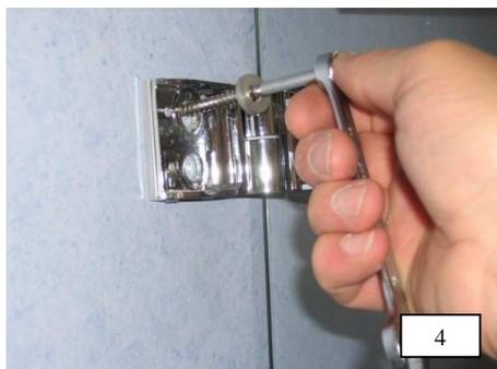
4. Seitenteil erneut ausrichten und beide Beschläge mit je 2x Schraube 6 x 80 mm und 2x U- Scheibe 6,4 mm befestigen.
