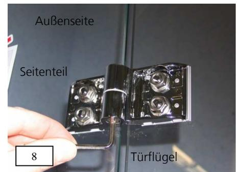
9. Falls erforderlich lässt sich der Türflügel zusätzlich noch über den Beschlag ausrichten. Hierzu mit geeignetem Montagewerkzeug SW 13 die Befestigungsmuttern M8 lösen und Einstellung vornehmen. Achtung vor dem Lösen der Befestigungsmuttern untere Scheibenkanten mit beiliegendem Kantenschutzprofil sichern. Die Befestigungsmuttern M8 sind anschließend mit einem Drehmoment von 15 Nm anzuziehen.
