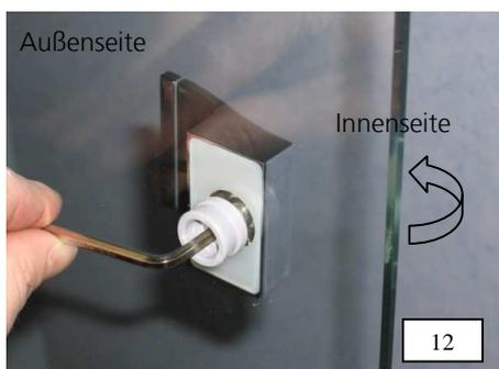
12. Erste Griffhälfte zusammen mit der Griffunterlage auf der Innenseite der Scheibe anlegen und mittels Senkschraube M6 x 20 und der Befestigungshülse aus Kunststoff von der Außenseite her durch die Bohrung hindurch befestigen.
