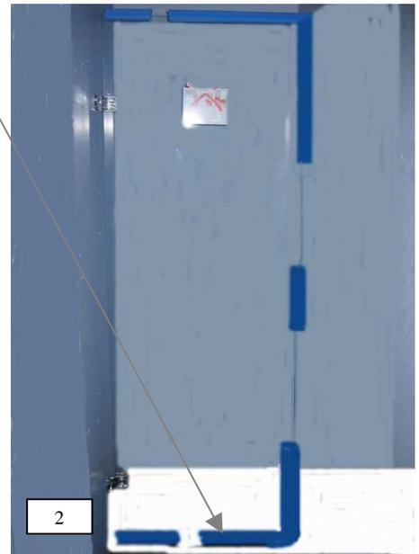
3. Tür an die Markierung setzen, lotrecht ausrichten und innenliegende Beschläge an die Wand schwenken.
