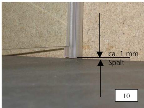
10. Balgdichtung unten zur Badewanne mit ca. 1 mm Spalt montieren. Die Balgdichtung darf nicht auf der Badewanne aufsitzen. Die Länge wird mit der Türscheibenoberkante bündig zugeschnitten.
