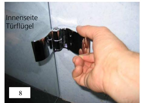
9. Baldichtung oben einige Zentimeter auf die hintere Scheibenkante des Türflügels aufstecken, somit wird ein abknicken verhindert.
