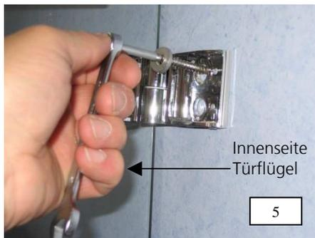
5. Anschließend Türflügel erneut ausrichten und jeweils beide Beschläge mit je 2x Schrauben 6 x 80 mm und 2x U- Scheibe 6,4 mm befestigen. Unterer Kantenschutz an der Tür kann nun entfernt werden.
