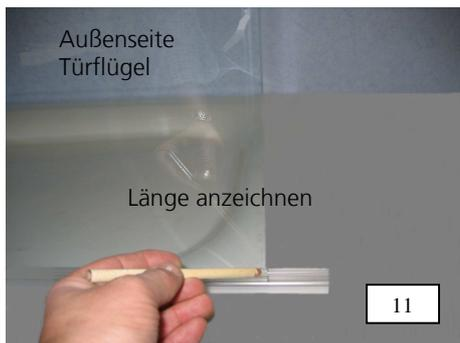
11. Die Länge der Wannendichtung wird von der Balgdichtung bis zur Vorderkante der Türscheibe gemessen, zugeschnitten und montiert.
