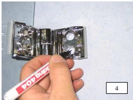
4. Bohrlöcher  $\varnothing$  8 mm anzeichnen, bohren und Dübel  $\varnothing$  8 mm setzen.
