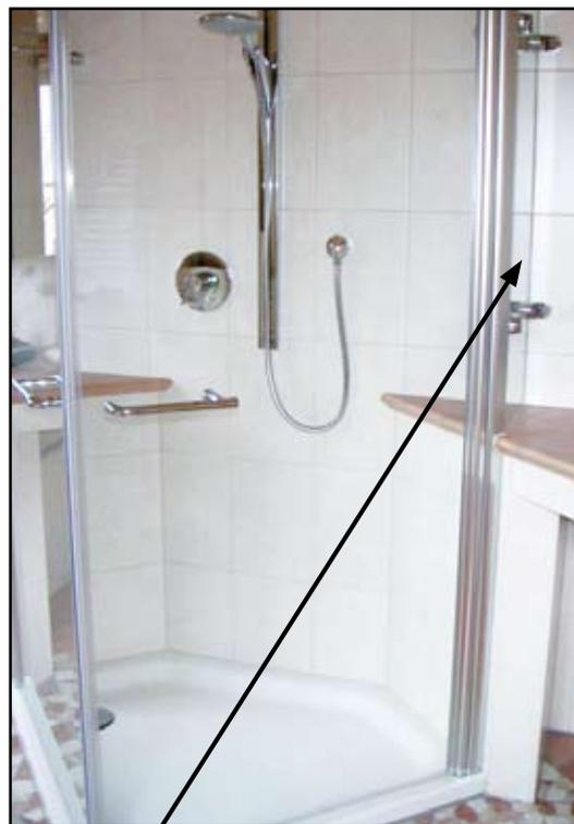
2 zusätzliche Seitenteile mit Sonderprofilen sind links und rechts notwendig.
