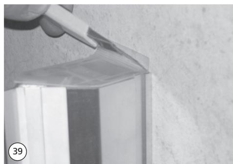
40. Wenn am schließseitigen Türprofil eine Abdeckung montiert ist, kann bei Bedarf deren mittlere Dichtlippe abgeschnitten werden.
