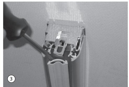
4. Gelenkeinheit an die Markierung setzen.
