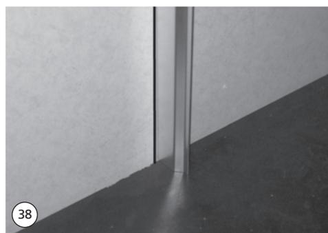
39. Obere Abdeckung auf die schließseitige Profileinheit aufstecken und überstehendes Material an der Riffelung abschneiden.
