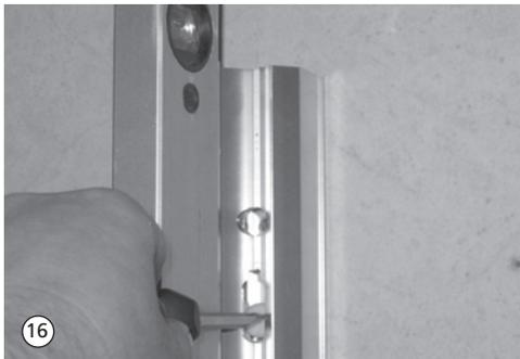
16. Schließseitige Profileinheit mit den weißen Kunststoffschrauben ebenfalls lotrecht ausrichten.
