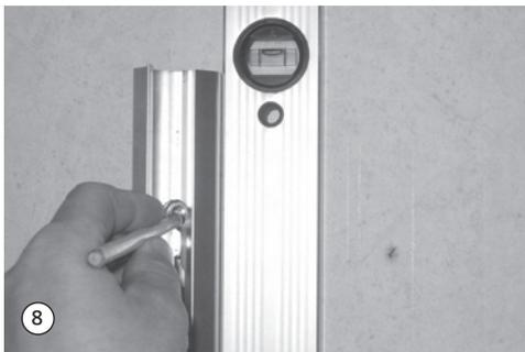
8. Lotrecht ausrichten, Bohrlöcher anzeichnen, bohren und Dübel setzen.
