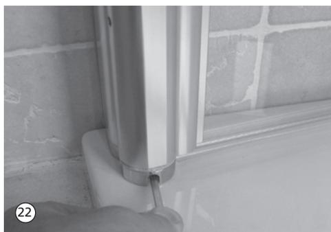
22. Bei Bedarf kann der Türflügel abgesenkt werden, Innensechskantschlüssel SW 3 verwenden. Auslieferungszustand ist oberste Stellung. Anheben ist nur möglich, wenn der Flügel demontiert ist.
