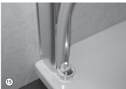
15. Die Gelenkdichtung ganz nach unten auf die Gelenkplatte drücken und anschließend auf der ganzen Länge vorsichtig in den Pfosten eindrücken.
