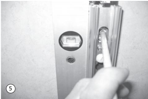
5. Lotrecht ausrichten und Bohrlöcher anzeichnen, bohren und Dübel setzen.
