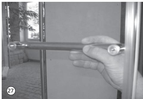
27. Gewindestifte des Griffes von außen durch die Bohrung des Türflügels durchstecken.
