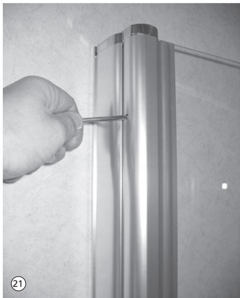
21. Türflügel lotrecht ausrichten. Hierzu wird der Flügel nach innen gefaltet, die Bohrungen der Justierschrauben am Drehprofil werden sichtbar. Mit Innensechskantschlüssel SW 4 Einstellung vornehmen.
