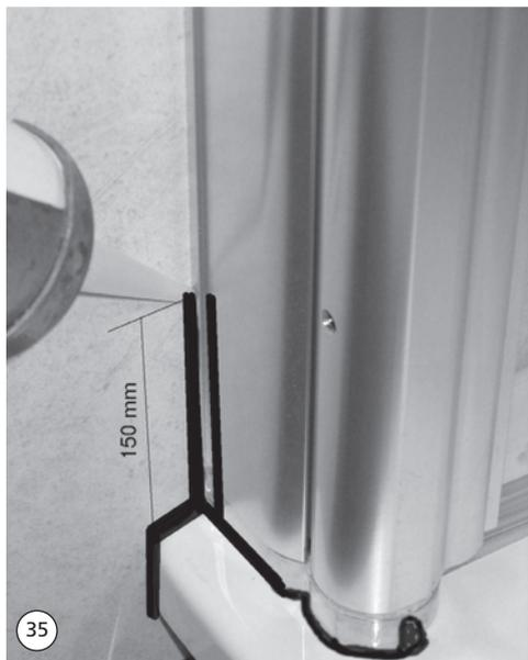
35. Versiegelung an der Gelenkeinheit von außen circa 150 mm senkrecht in der Höhe und waagrecht an der Gelenkplatte bis zur vorderen Öffnung. Diese komplett versiegeln.
