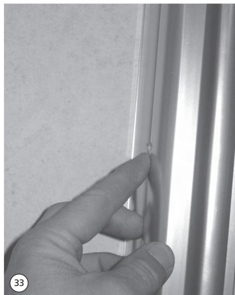
34. Beim Montieren der Wannendichtung am Türflügel darauf achten, dass der schräge Abweiser zur Innenseite zeigt. Beim Zuschneiden der Länge muss die Dichtung hinten an der Gelenkplatte und vorn am schließseitigen Profil anliegen.
