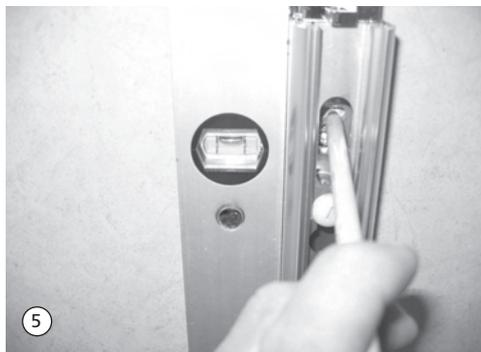
5. Lotrecht ausrichten und Bohrlöcher anzeichnen, bohren und Dübel setzen.
