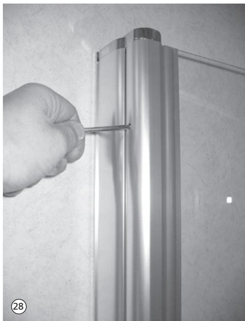
28. Türen schließen und die Flügel auf einen parallelen Verlauf zur Wanne oder Fuge hin kontrollieren. Eventuell Korrekturen mit den Justierschrauben vornehmen wie unter Punkt 17 beschrieben.
