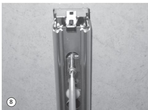
8. Lotrecht ausrichten und mit Spaxschrauben 4,5 x 45 mm befestigen.
