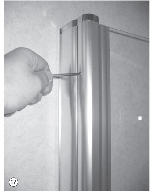
18. Bei Bedarf kann der Türflügel abgesenkt werden, Innensechskantschlüssel SW 3 verwenden. Auslieferungszustand ist oberste Stellung. Anheben ist nur möglich, wenn der Flügel ausgebaut ist.
