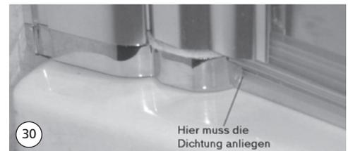
31. Versiegelung an den Gelenkeinheiten von außen circa 150 mm senkrecht in der Höhe und waagrecht an der Gelenkplatte bis zur vorderen Öffnung. Diese komplett versiegeln.
