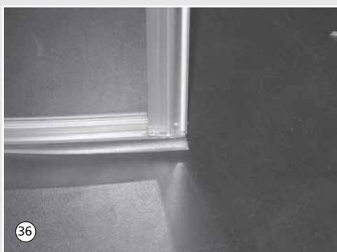
36. Wannendichtung am gebogenen Flügel so montieren, dass sie mit der Ausklinkung vorn an der Türmagnetdichtung anliegt und hinten mit der Scheibenkante bündig abschließt. Anzeichnen und zuschneiden.
