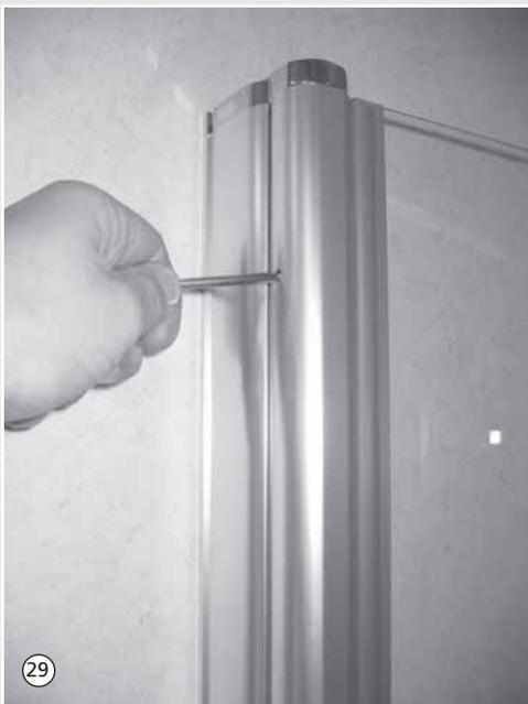
29. Türen schließen und die Flügel auf einen parallelen Verlauf zur Wanne oder Fuge hin kontrollieren. Eventuell nochmals Korrekturen an den Justierschrauben oder den Gelenkteilen vornehmen wie unter Punkt 22 beschrieben.
