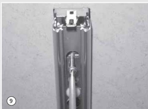
9. Ausrichten und mit Spaxschrauben 4,5 x 45 mm befestigen.
