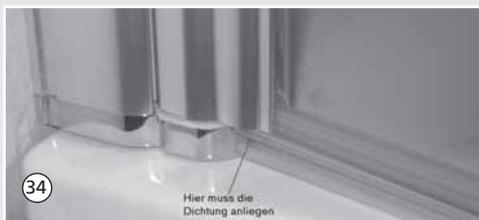
34. Beim Montieren der Wannendichtungen an den Flügeln darauf achten, dass der schräge Abweiser zur Innenseite zeigt. Beim Zuschneiden der Länge am geraden Flügel muss diese hinten an der Gelenkplatte anliegen.
