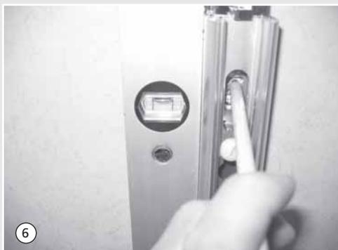
6. 4 Bohrlöcher anzeichnen, bohren und Dübel einsetzen.
