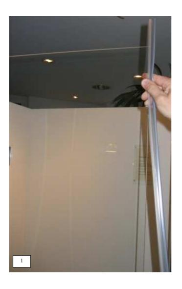
Türmagnetdichtung auf den schließseitigen Flügel oben einige Zentimeter auf die Scheibe aufstecken. Somit wird verhindert, dass die Dichtung abknickt und dadurch unbrauchbar wird.
