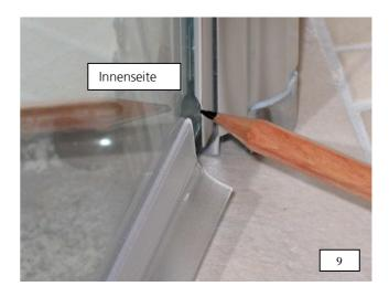
10. Pfeil zeigt die endgültige Position der Dichtung an der unteren Gelenkplatte.
