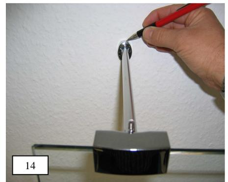
15. Gelenkkopf wieder von der Gelenkplatte lösen. Lochdurchmesser 8 mm an markierter Position bohren. Dübel setzen und Stockschraube M6 x 60 bis auf eine Restlänge von 6 - 8mm eindrehen. Anschließend die Gelenkplatte aufschrauben und senkrecht ausrichten.
