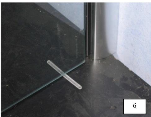
6. Je nach Bedarf Verglasungsklötze in 2 oder 3 mm Stärke vor das Wandprofil auf den Wannrand oder Fliesenboden legen. Kantenschutz unten und profelseitig von der Scheibe entfernen. Scheibe vorsichtig darauf absetzen, in den Aufnahmespalt zwischen den Profilen einschieben und Klemmschrauben anziehen.
