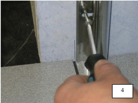
4. Wandprofil erneut an die Markierung setzen, lotrecht ausrichten und mit den Spaxschrauben 4,5 x 45 mm verschrauben.
