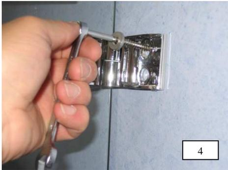
4. Scheibe erneut ausrichten und beide Beschläge mit je 2 Schrauben 6 x 80 mm und 2 U- Scheiben 6,4 mm befestigen.
