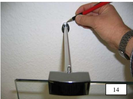
14. Das Halterohr an die Wand schwenken und die Position der Befestigungsbohrung anzeichnen. Dabei waagerechte Ausrichtung des Halterohres beachten.
