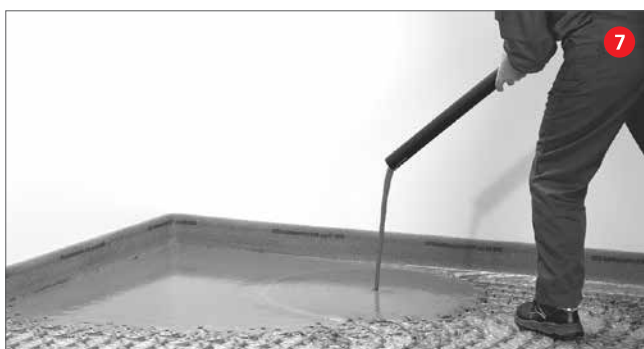
7. Applicazione del filler e massa sigillante
