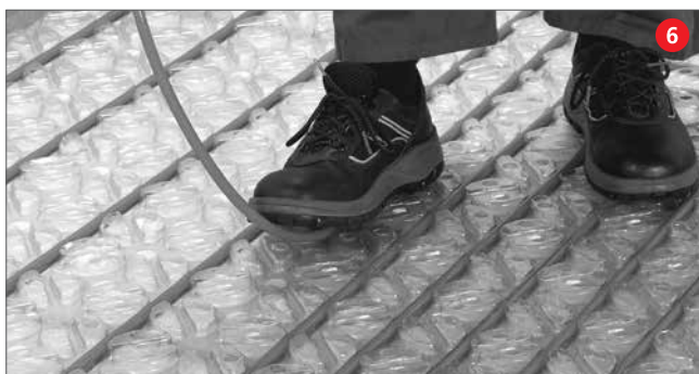
6. Posa del tubo
