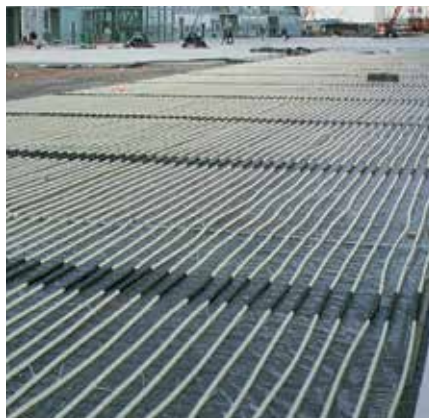
Riscaldamento a superficie industriale Roth
