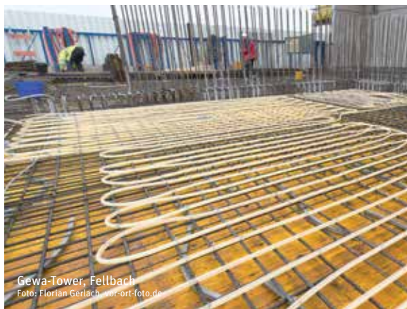
Climatizzazione del nucleo in cemento Roth alla Gewa Tower - 5.300 m 2 di superficie attiva con Roth Isocore® - 45.000 m sistema di tubi DUOPEX S5® - 20 mm
